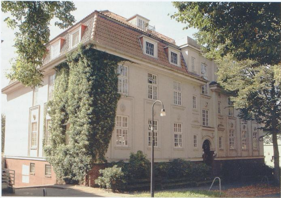
Wohnhaus mit Werkwohnungen des Bremer Vulkan, Weserstraße 69-70, 1922, August Abbehusen, Straßenansicht
