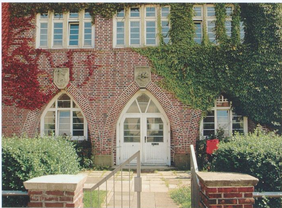
Wasserturm Blumenthal, Haupteingang
