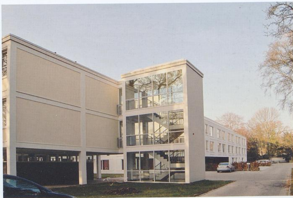
Wohnanlage des US-Generalkonsulats, östl. Treppenhaus mit neuer Verglasung, im Hintergrund der Neubau von 2011
