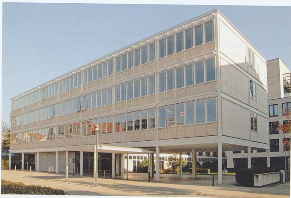
Ehemaliges Amerikanisches Generalkonsulat nach der Sanierung
