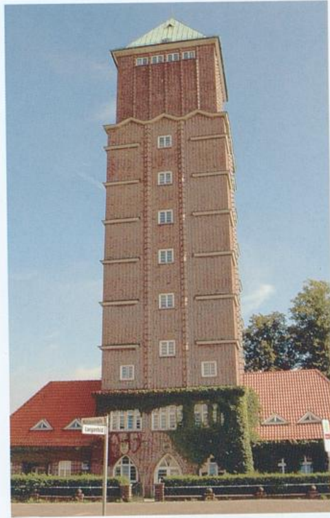
Wasserturm Blumenthal, Mühlenstraße 62, 1927–1928, Michael Fischer
