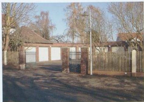
Garagenanlage der BWK-Wohnhäuser, Wigmodistraße 40, 1934
