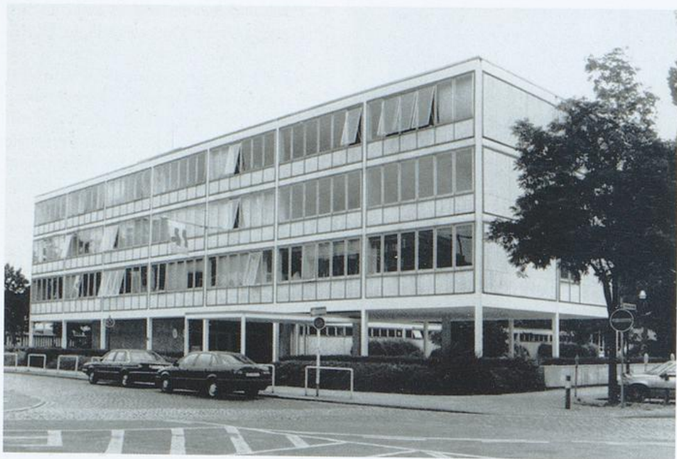
Ehemaliges Amerikanisches Generalkonsulat vor der Sanierung, 1993
