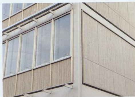
Generalkonsulat, Fassadendetail mit neuer Beschattungsmechanik
