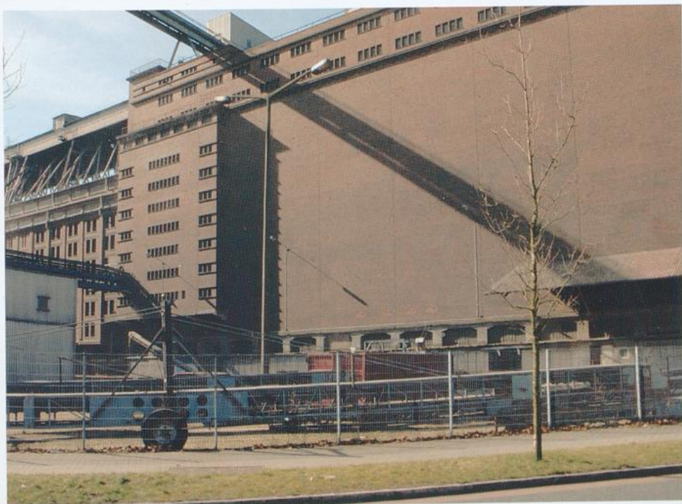
Getreideverkehrsanlage, Silo I (am linken Bildrand) und II
