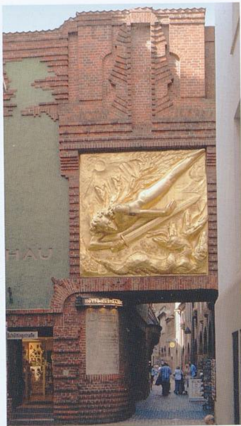
Böttcherstraße, Zugang nach der Veränderung
