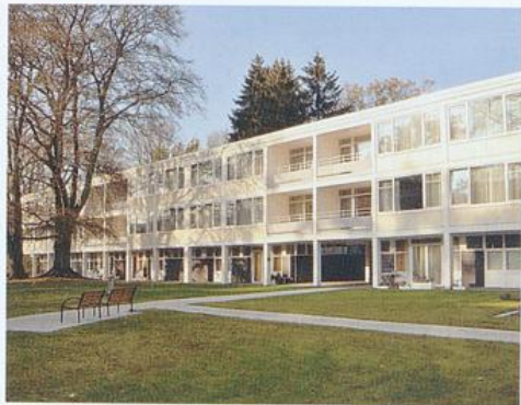
Wohnanlage des US-Generalkonsulats, jetzt Seniorenpflegezentrum, Südseite
