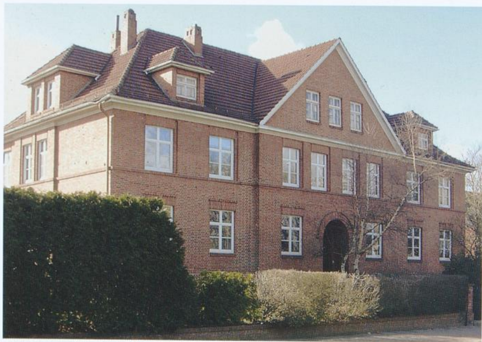
Wohnhaus mit Werkwohnungen der BWK, Lüssumer Straße 35, 1922, Straßenansicht
