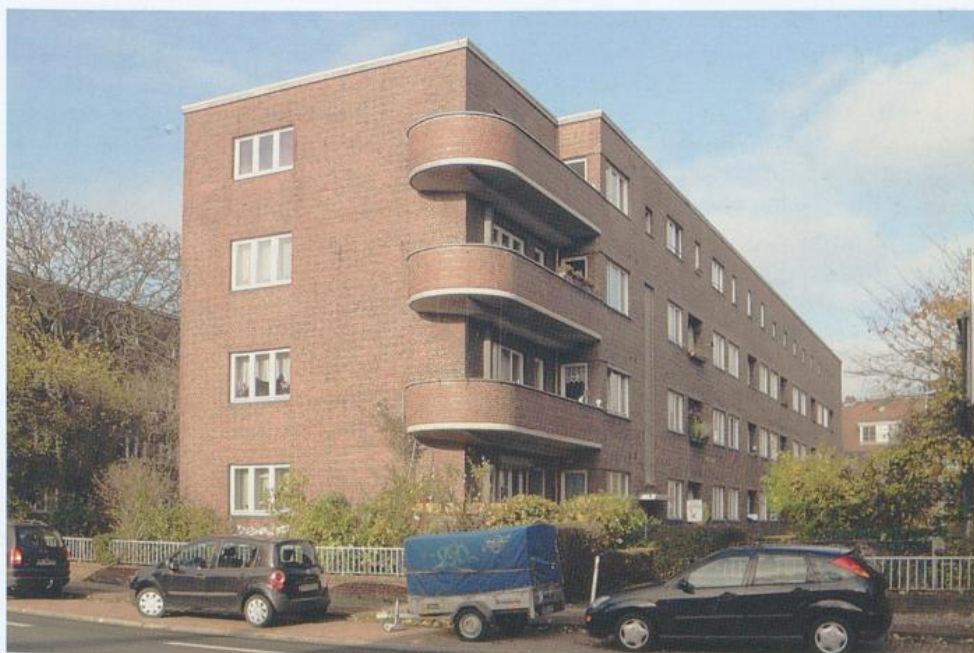
Einer der Blocks der AfA-Wohnanlage, Bismarckstraße
