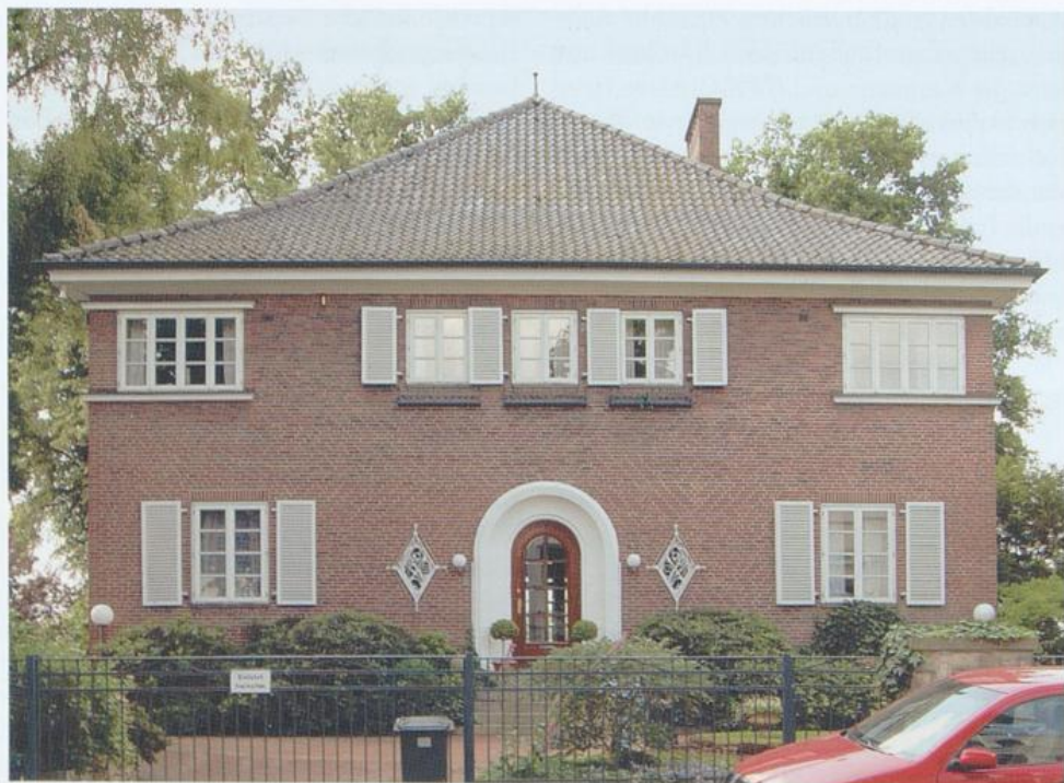
Haus Buermeyer, Weserstraße 78, 1927–1928, Behrens & Neumark
