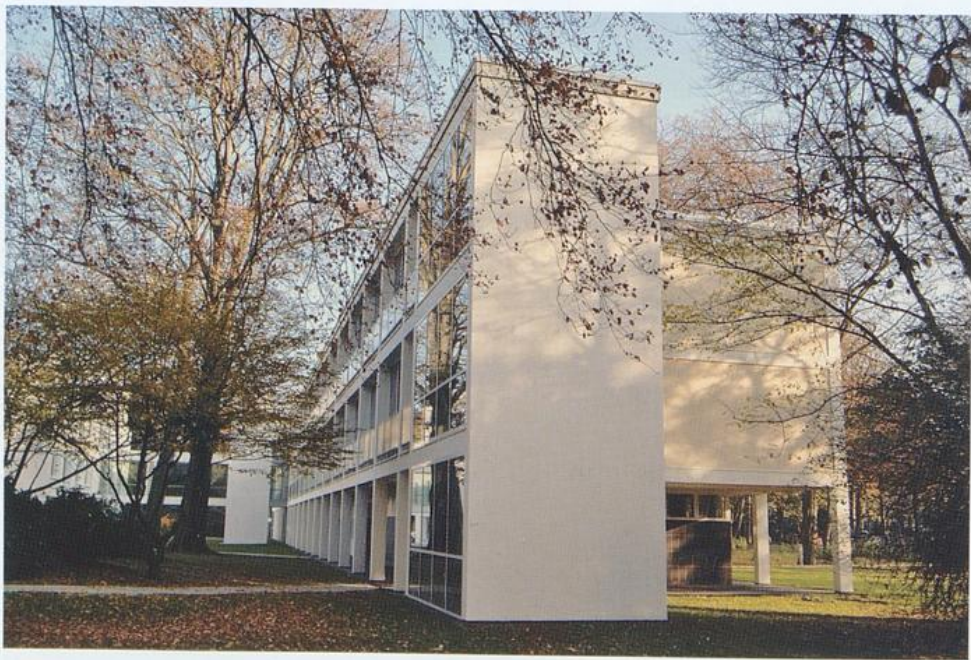
Ehemalige Wohnanlage des US-Generalkonsulats, Blick von Westen auf die jetzt verglasten Laubengänge
