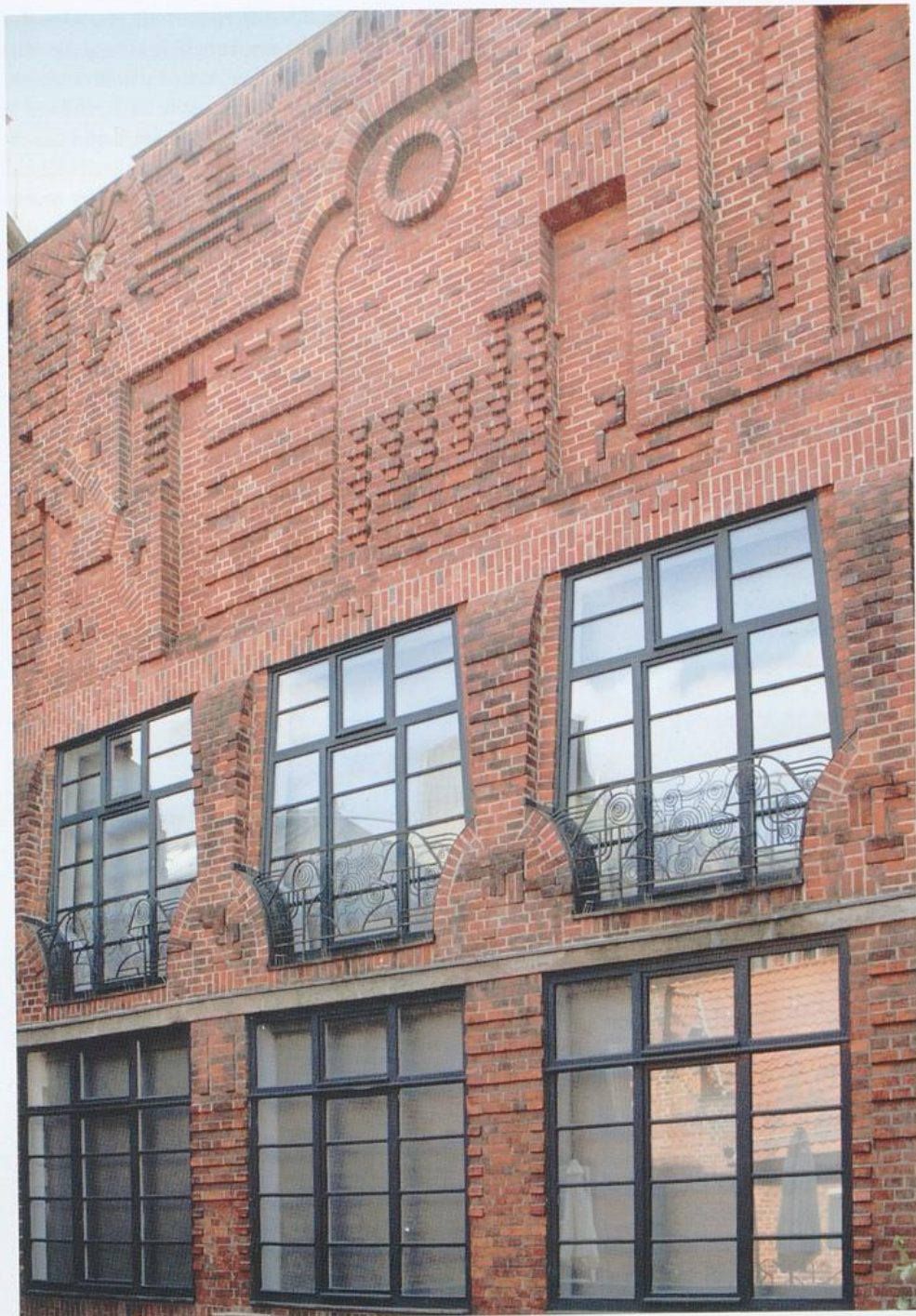
Paula-Becker-Modersohn-Haus, Wand im Handwerkerhof
