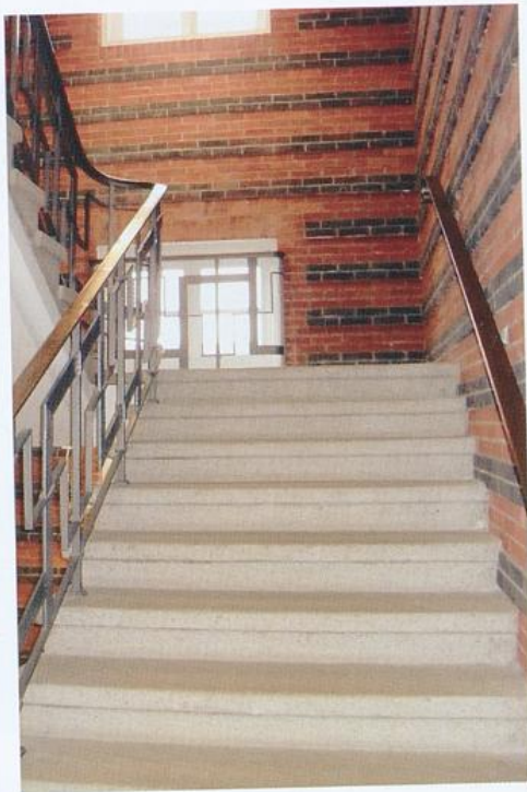
Treppenhaus nach Instandsetzung
