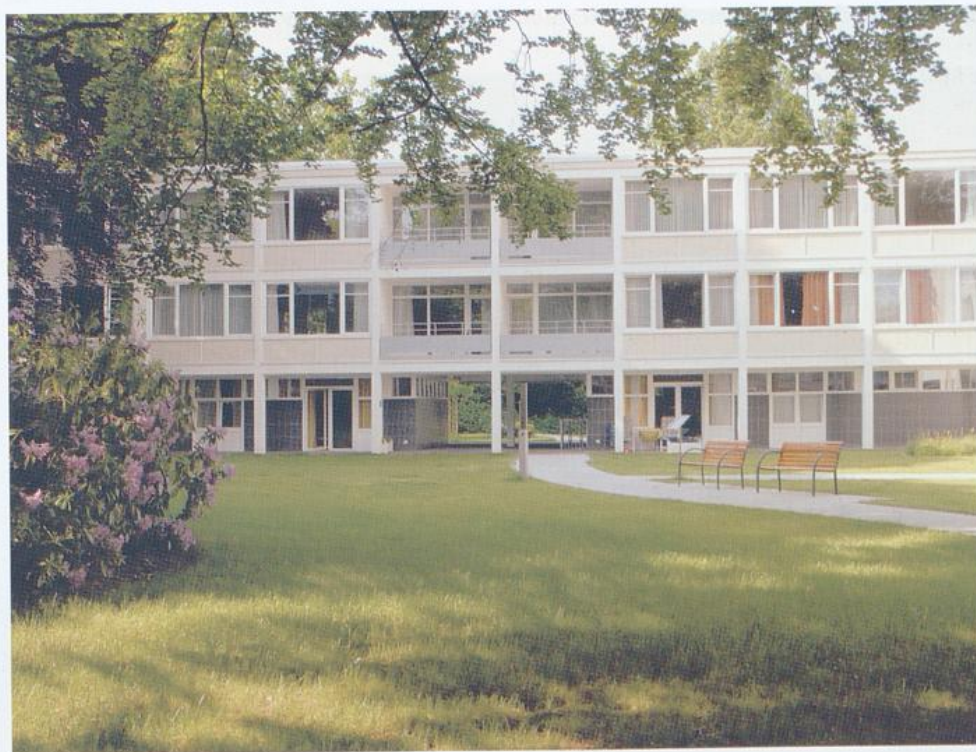
Wohnanlage des US-Generalkonsulats nach Umbau zum Seniorenpflegezentrum
