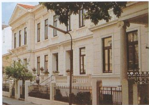
Objektsanierung von »Bremer Häusern« in der Bleicherstraße 41-47
