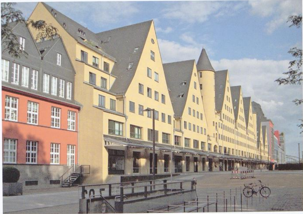
Abb. 5: Köln, Rheinauhafen, Stückgutlagerhaus, sogenanntes Siebengebirge
