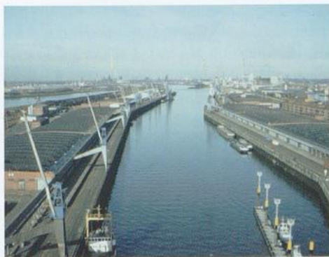
Überseehafen vor der Verfüllung
