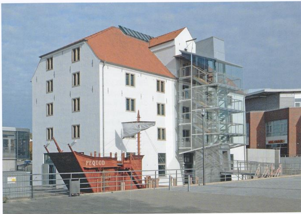
Lange-Speicher mit neuem Erschließungsturm, 2009
