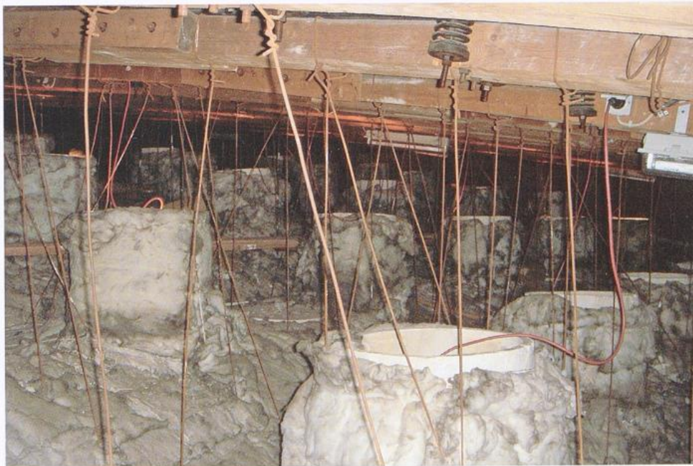
Die abgehangene innere Saaldecke nebst Lampentöpfen, abgedeckt mit Glaswolle. Oben eine der Federn, mit denen die äußere Saaldecke an der Dachkonstruktion befestigt ist
