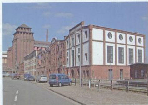
Bachmann-Speicher und Roland-Mühle, Holz- und Fabrikenhafen
