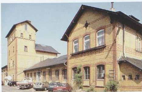
Abb. 6: Köln, Rheinauhafen, ehemalige hydraulische Kraftzentrale
