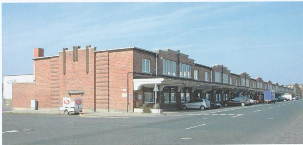
Packhalle XII, Am Lunedeich 22/40
