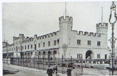
Abb. 2: Köln, Rheinauhafen, Lagerhaus 2, ursprünglicher Zustand
