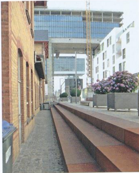
Abb. 10: Köln, Rheinauhafen, angehobenes Bodenniveau, 2009
