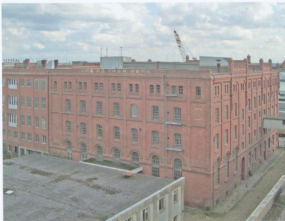
Ehemalige Kaffee-HAG-Fabrik, Kaba-Gebäude
