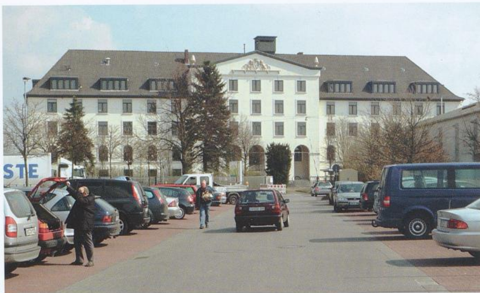
Kaserne Rotersand, Bürgermeister-Smidt-Straße 217
