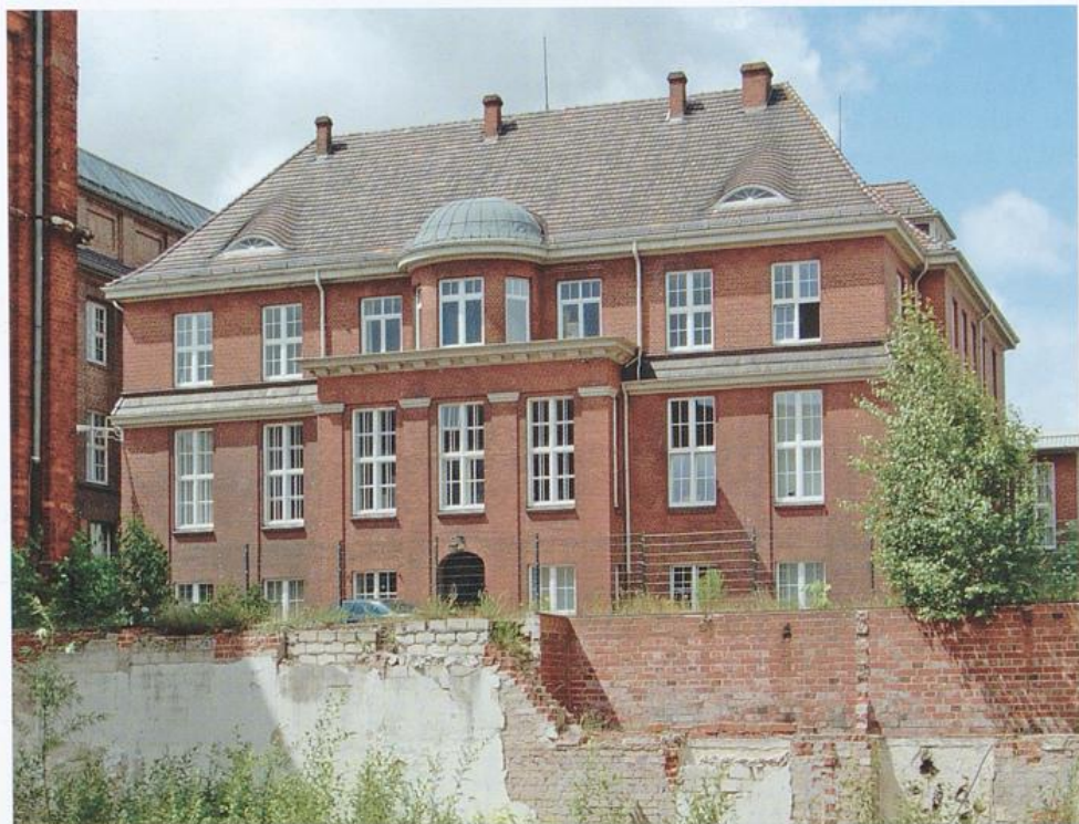
Technische Verwaltung Nr. 50, Ansicht von Osten, Aufnahme 2009
