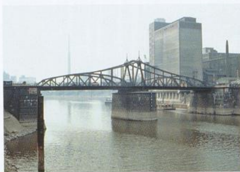
Abb. 16: Krefeld, Drehbrücke zwischen Rheinhafen und Osthafen (1903–1906)
