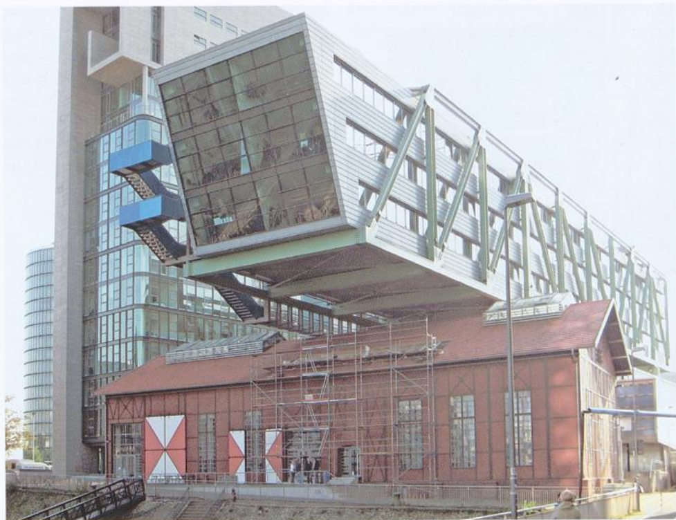
Abb. 12: Düsseldorf, ehemalige Kraftzentrale am Handelshafen, erdrückt von der Moderne
