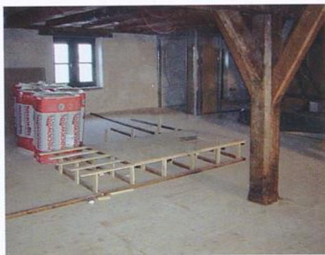
Lange-Speicher, Inneres. Ein partieller Niveauausgleich für einen Büro-Arbeitsplatz während der Bauphase
