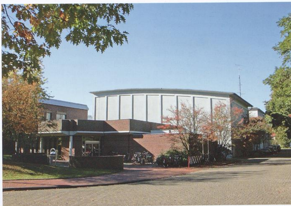
Sendesaal mit neuem Foyergebäude, heutiger Zustand
