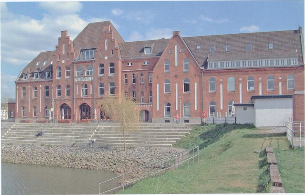
Ehemalige Feuerwache und Zollamt, Holz- und Fabrikenhafen
