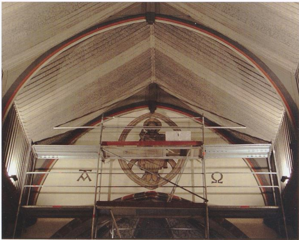
Der eingerüstete Triumphbogen zu Beginn der Restaurierung
