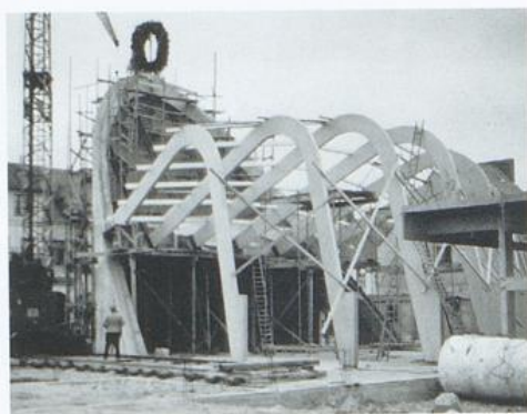
Auferstehungskirche Hastedt: Das beim Richtfest aufgenommene Foto lässt die schwierigen Verbindungspunkte zwischen den beiden Formelementen gut erkennen
