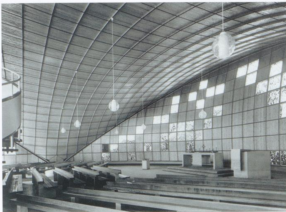
Im Innenraum der St.-Lukas-Kirche zeichnet sich die konstruktive Struktur klar ab
