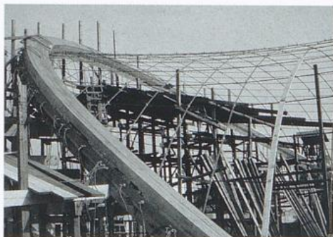
St. Lukas im Bau: Druckbogen und Seilnetz
