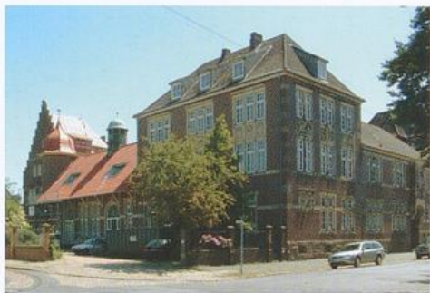
Ehemaliges Hauptzollamt Bremerhaven während der Sanierung, 2006
