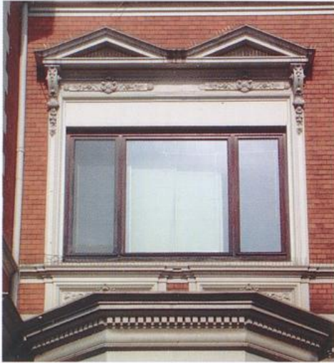
Fassadenzerstörung durch Ignorierung historischer Fensterformate. Rechts: intakte Fensteranordnung
