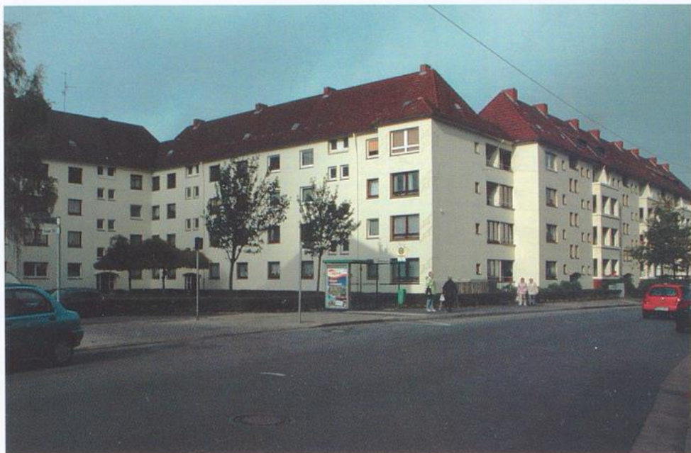
Bürgermeister-Smidt-Straße 240/254, 1938–1939 von Hans Scharoun
