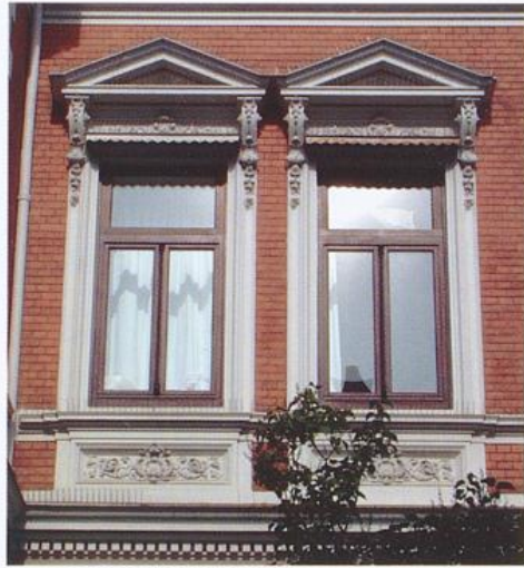
Fassadenzerstörung durch Ignorierung historischer Fensterformate. Rechts: intakte Fensteranordnung
