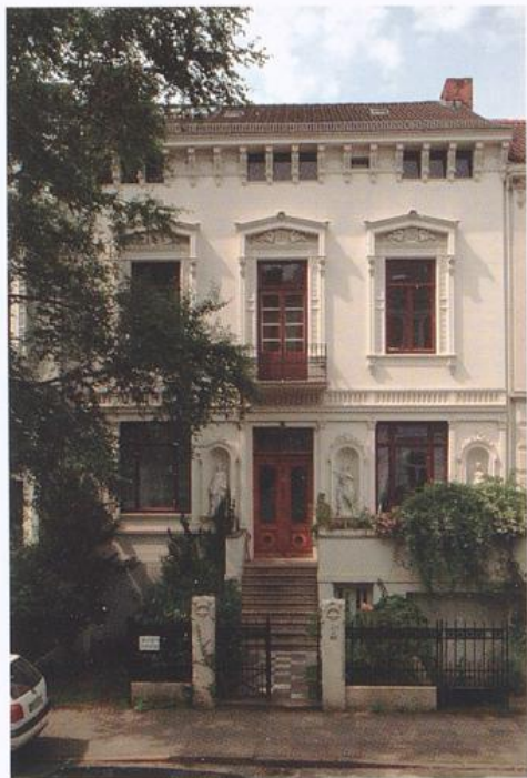
Großbürgerliches »Bremer Haus« in der Mathildenstraße, erbaut 1870 /71 durch den Baumeister Lüder Rutenberg. Das Besondere dieses Haustyps ist, dass sich die Haustür in der Mitte befindet. Die Treppe liegt quer hinter dem rechten Vorderzimmer, welches isoliert liegt und anfangs als Empfangszimmer diente
