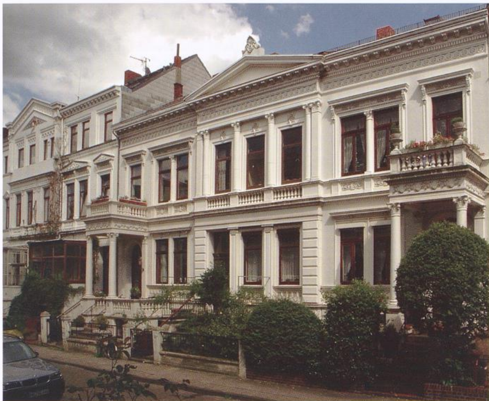
Palastfassade in der Herderstraße
