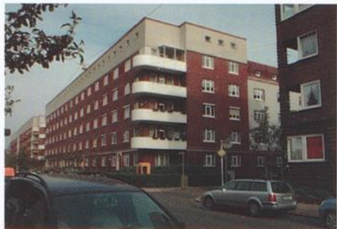
IV. und V. Bauabschnitt der Gemeinnützigen Wohnungsfürsorge an der Bürgermeister-Smidt-Straße 187/205, 1929–1931 von Willy Rump
