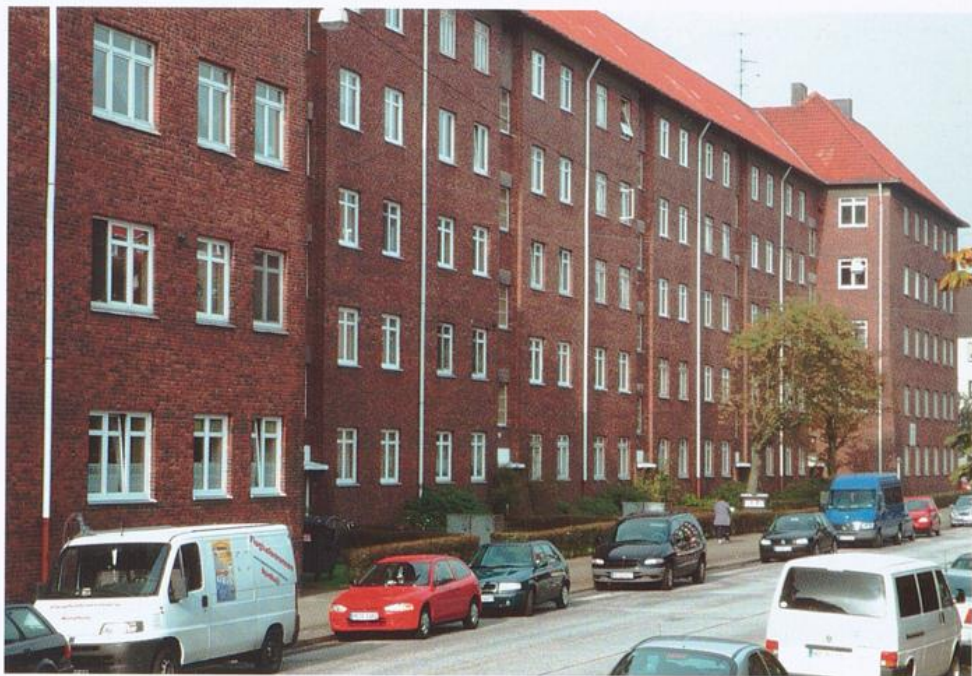
Bürgermeister-Smidt-Straße 224/238, 1935–1936 von Hans Scharoun
