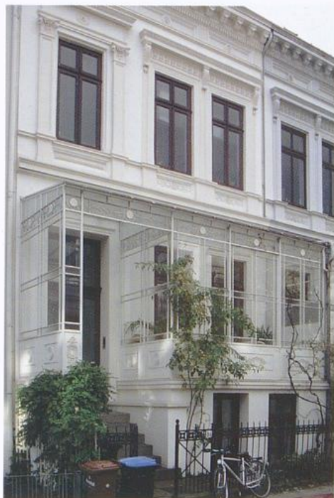
»Bremer Haus« mittlerer Größe in der Besselstraße, erbaut 1870 von Lüder Rutenberg. Der Wintergarten wurde nach Befund anderer baugleicher Häuser rekonstruiert, da der hier ursprünglich vorhandene verloren gegangen war
