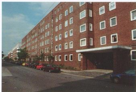
Wohnanlagen entlang der Bürgermeister-Smidt-Straße. Im Vordergrund der X. Bauabschnitt der Stadt Bremerhaven, 1928–1929 von Julius Hagedorn und Fritz Boysen
