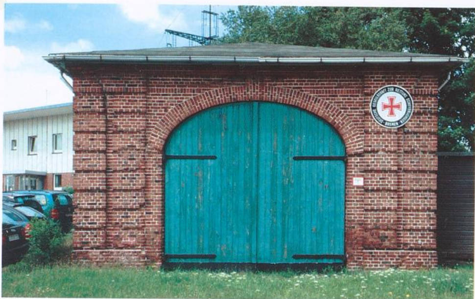
Bremerhaven: Bootsschuppen der DGzRS – Einfachste Architektur mit hohem Denkmalwert
