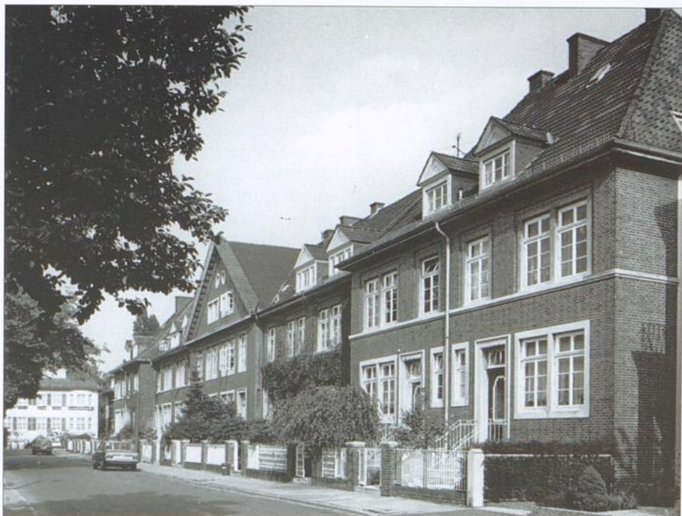
Dieses Ensemble geräumiger »Bremer Häuser« in der Gravelottestraße wird im Volksmund auch »Bremer Sanssouci« genannt. Erbaut wurde es in den Jahren 1924 – 26 durch den Architekten Carl Krahn
