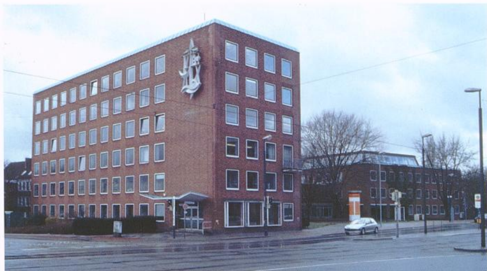
Abb. 4: Gebäude der Wasser- und Schifffahrtsdirektion, Franziseck. Im Hintergrund: Katasteramt
