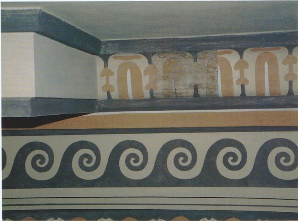
Restaurierte Gebälkzone, Neufassung mit Befundfenster (2005)
