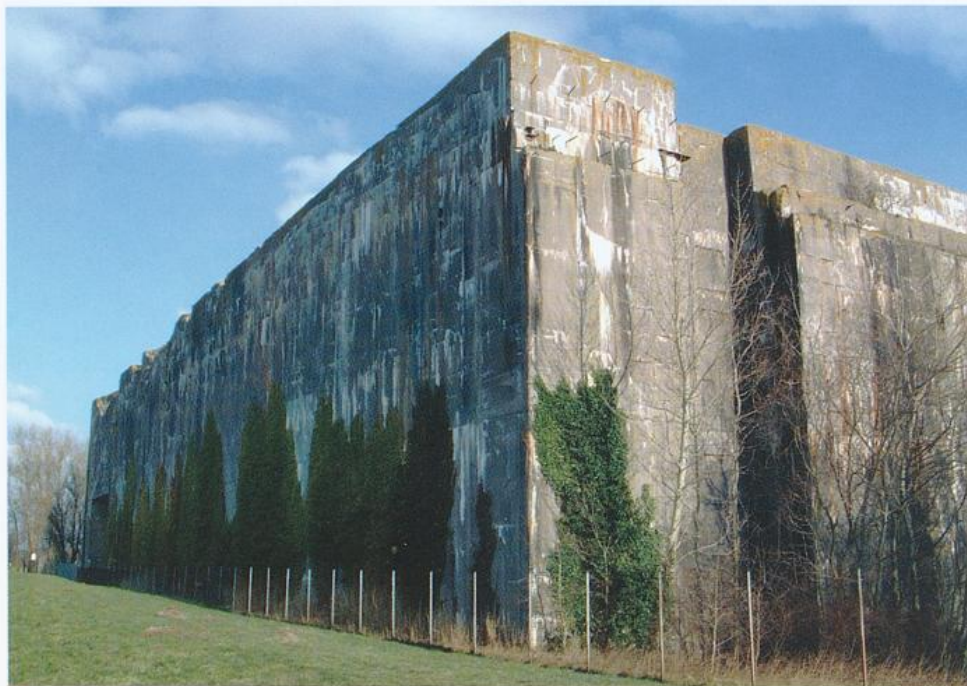
Bremen-Farge, U-Boot-Bunker »Valentin« (2005)
