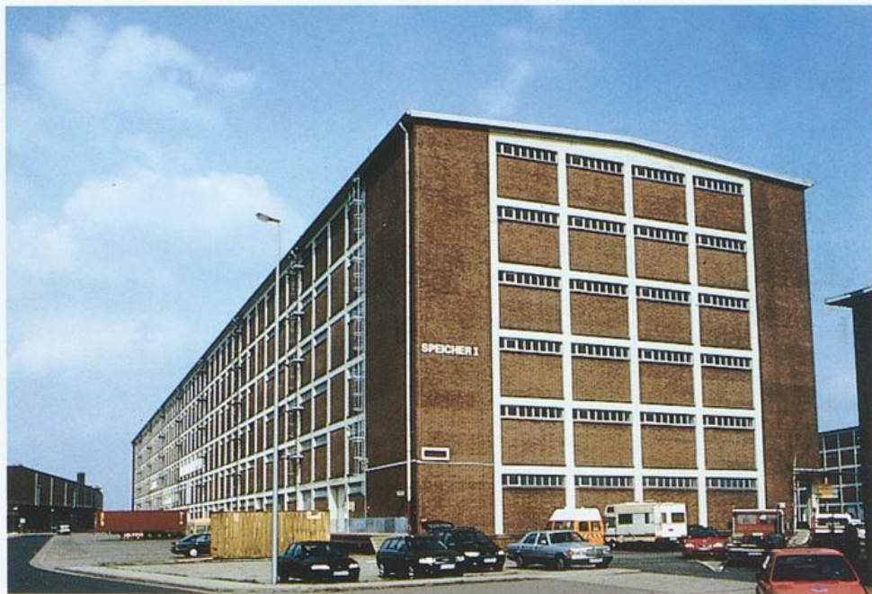
Speicher I am Europahafen, vor dem Umbau (2005)
