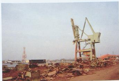
Demontage der Erzumschlagsanlage (1994)
