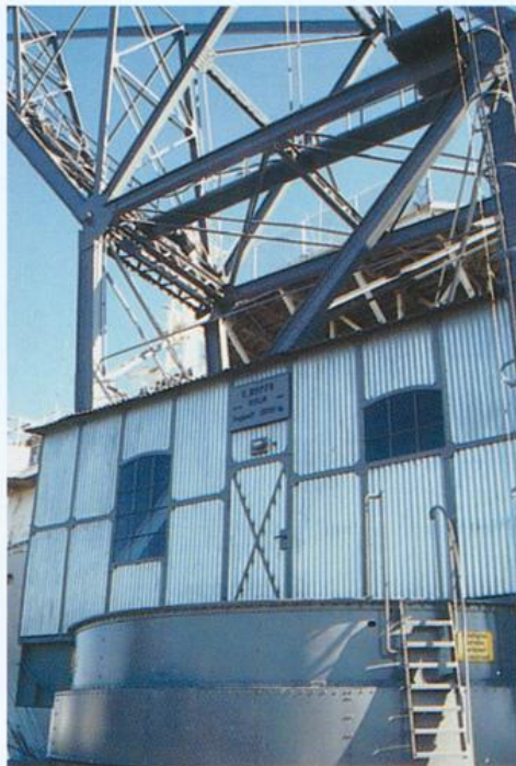
Druckwasserdrehkran am Kaiserhafen I (1997)
