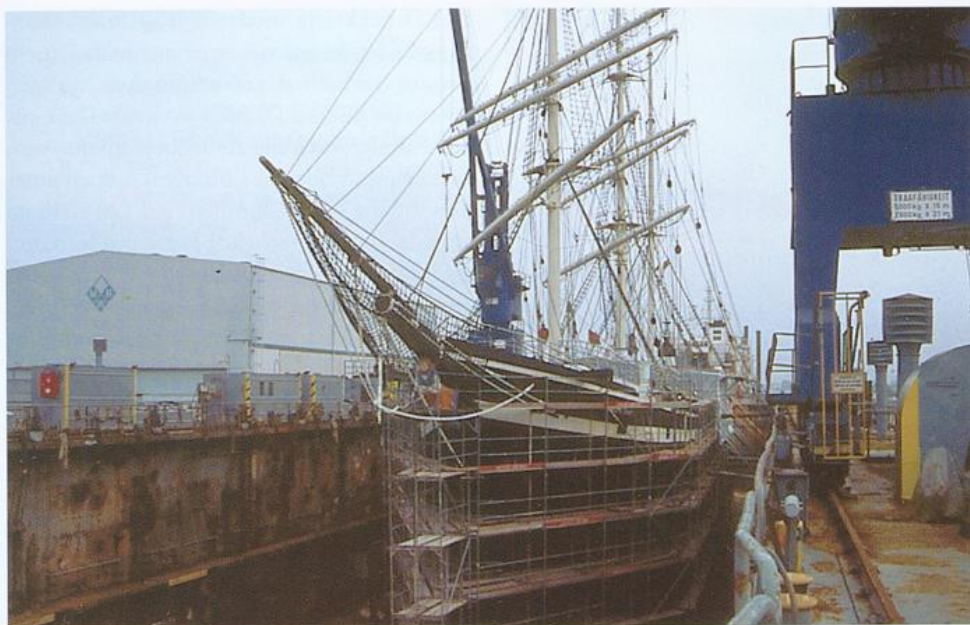
Zur Instandsetzung eingerüstet im Dock (2001)
