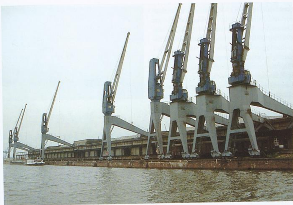
ABC-Schuppen mit Halbportalkranen (1985)
