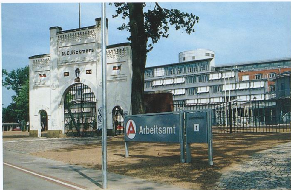
Portal der ehemaligen Rickmers-Werft und Arbeitsamt Bremerhaven (1993)
