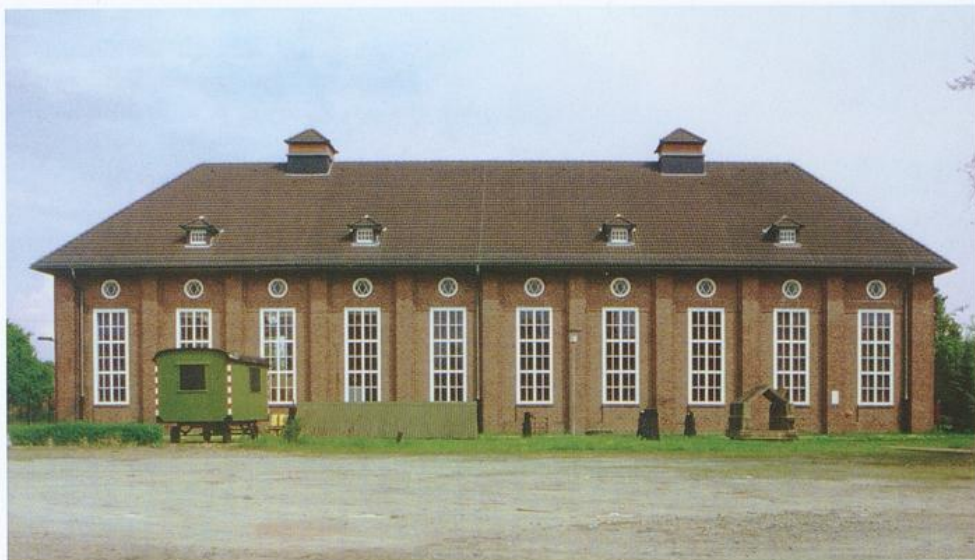
Altes Pumpwerk, Maschinenhalle
