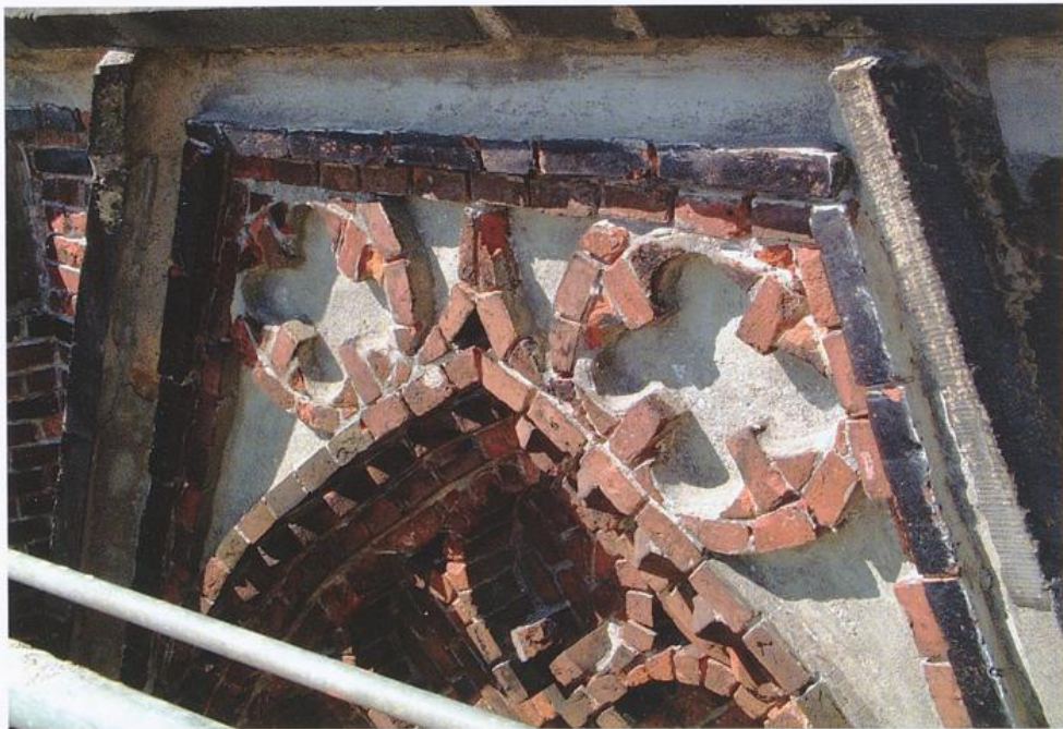
Zustand zu Beginn der Sanierung - Wimperg unterhalb des Turmhelms
