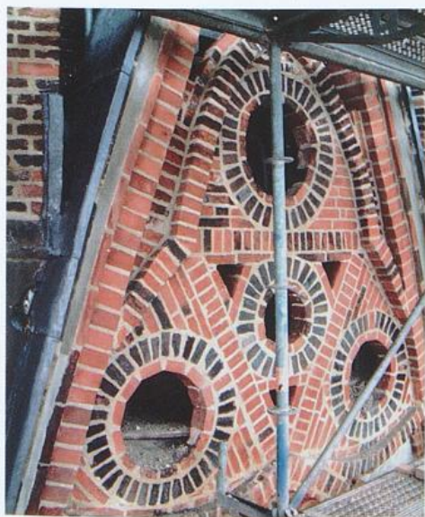
Zustand nach der Sanierung – Wimperg über der Turmuhr
