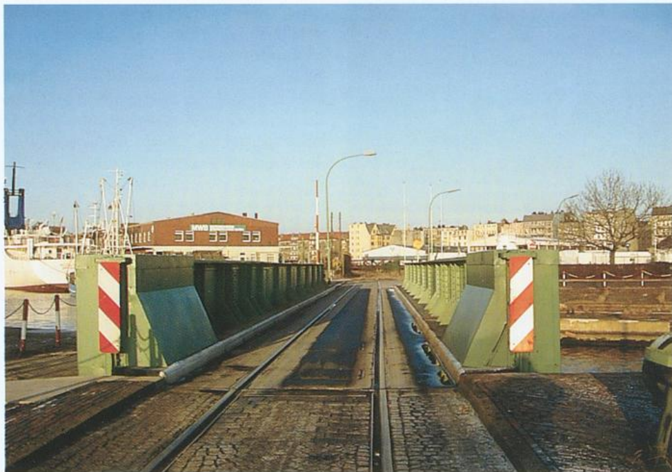
Eisenbahndrehbrücke über die Verbindungsschleuse zwischen dem Neuen Hafen und Kaiserhafen I (1992)
