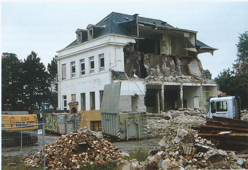
Abbruch des Verwaltungsgebäudes der einstigen Schiffbaugesellschaft Unterweser (2001)
