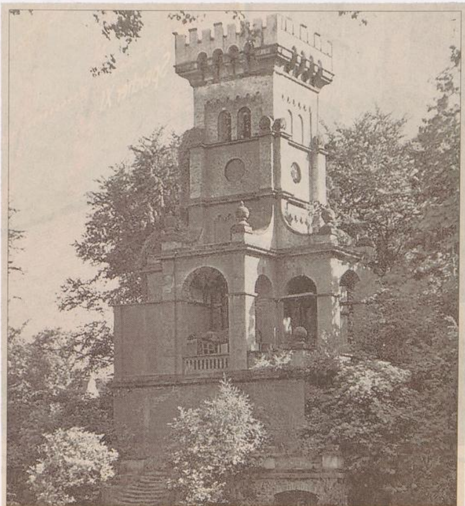
Auf 50 000 bis 60 000 DM schätzt man die Reparaturkosten für den Aussichtsturm im Bürgerpark. Der Bürgerparkverein kann bei seinem Jahresetat von 166 000 Mark das Geld keinesfalls aufbringen. Das Bauwerk ist Jahrgang 1890. Bis 1941 stiegen Hunderttausende die 200 Stufen hinauf. Nach dem „Kriegsdienst“ wurde der Turm vor dem Einmarsch der Engländer von den Deutschen selbst teilweise zerstört. (24. August 1950) Foto: Herm. Jakob
